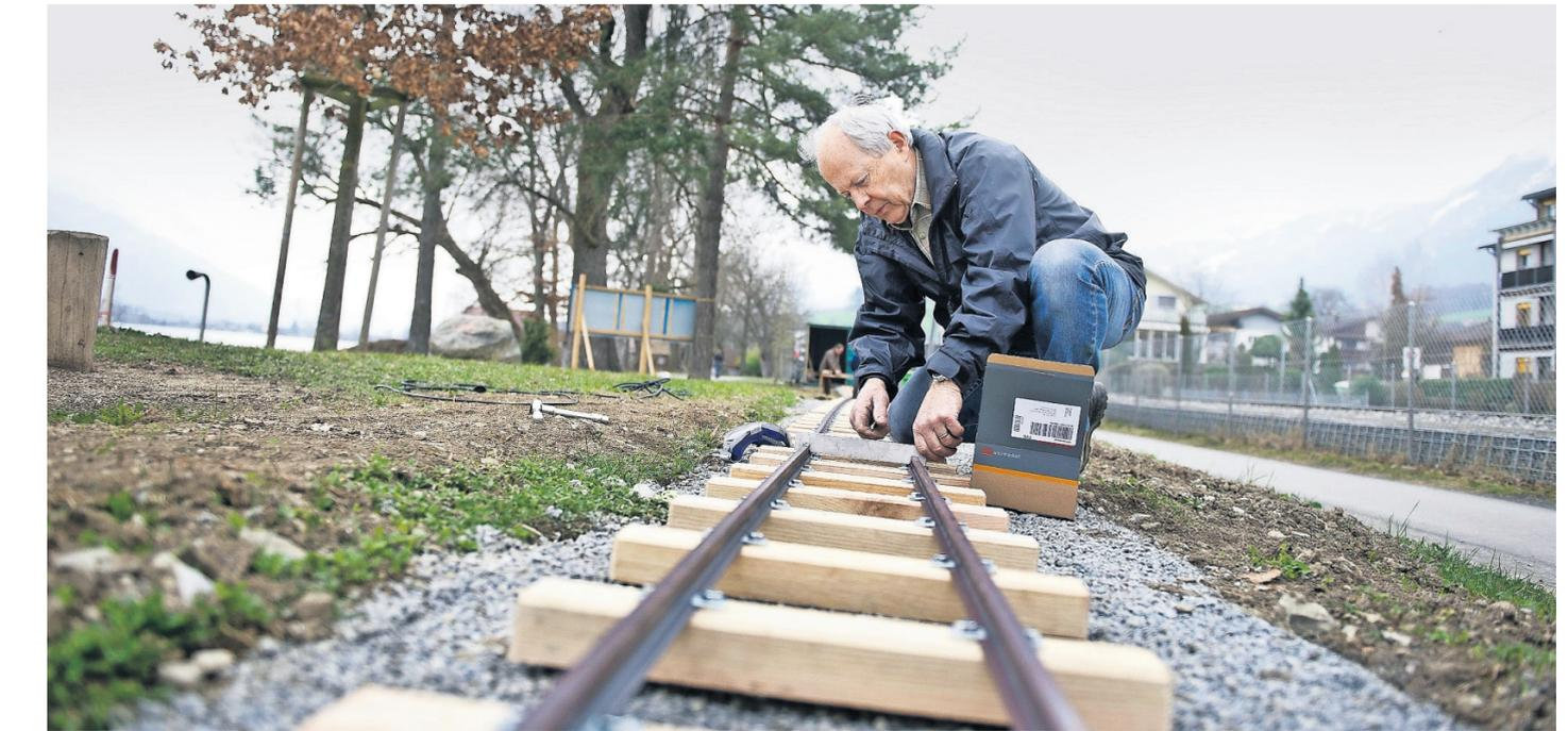
Fronarbeiter wie Hans Vogler verlegen rund 200 Meter Gleise für die Sumsi-Bahn bei der Badi in Sachseln.
